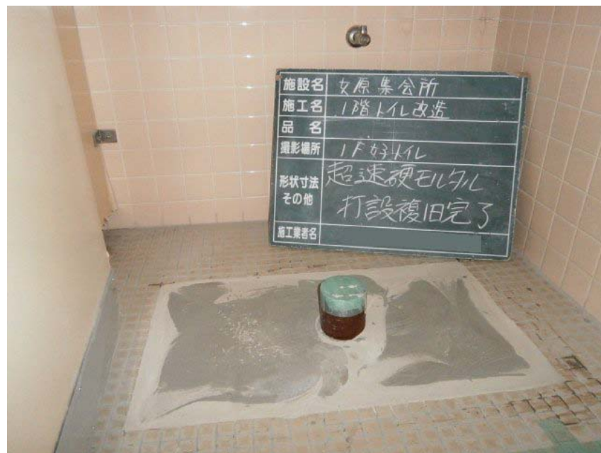
速乾モルタル打設
